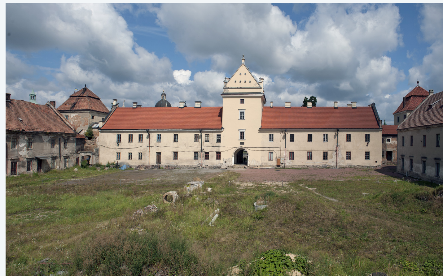
Południowo-wschodnie skrzydło zamku w Żółtkwi. Przejście bramne od strony dziedzińca.
