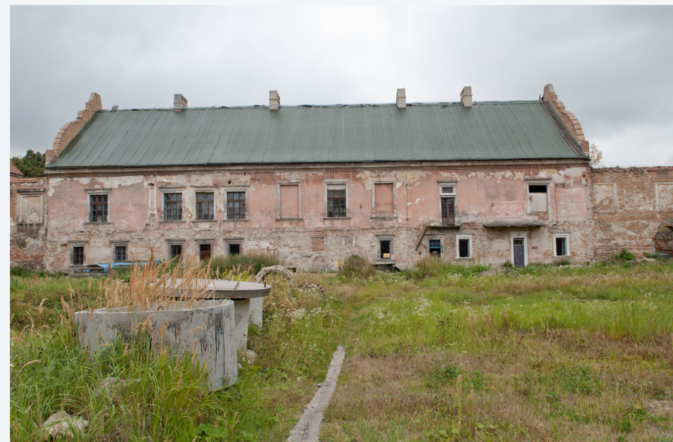
Północno-zachodnie skrzydło zamku w Żółtkwi - część pałacowa. Na piętrze mieściły się pomieszczenia reprezentacyjne.
