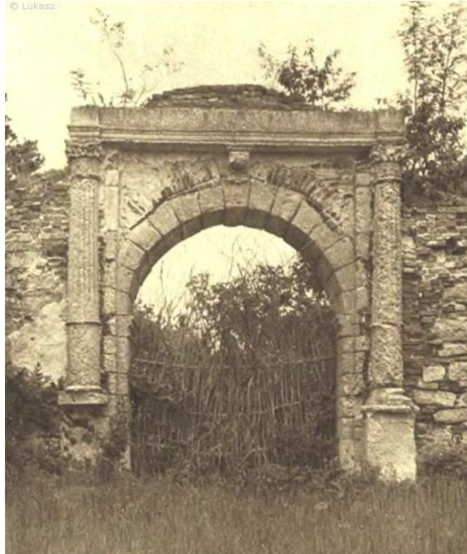
Ryc. Biały Kamień, portal bramy wjazdowej, widoczne fragmenty zdegradowanych tynków i kamienna deloracja architektoniczna, fot. Za A. Czołowski, B. Janusz, Przeszłość i zabytki województwa tarnopolskiego , Tarnopol 1926
